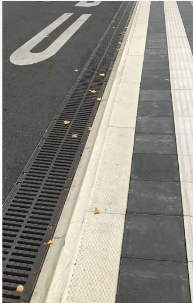
Abbildung 27: Haltestelle mit Spurführung und zweiter Hohlkehle
