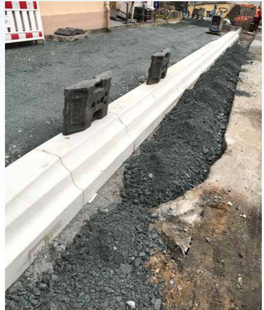
Abbildung 20: Einbau eines Hochbordes während der Baumaßnahme
