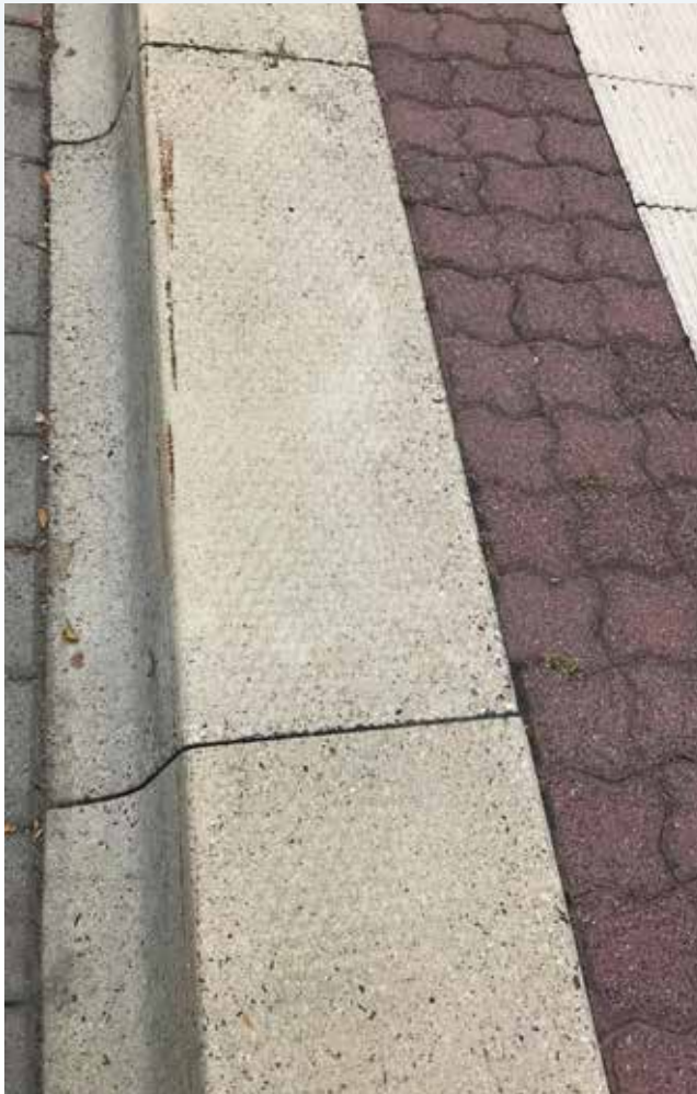
Abbildung 26: Langjährig in Betrieb befindliches Hochbord mit Spurführung
