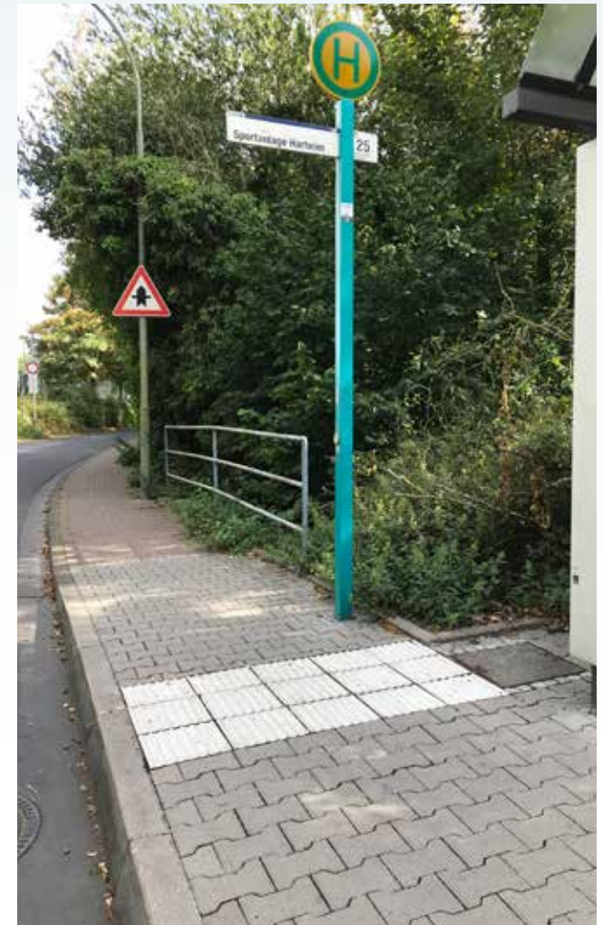
Abbildung 23: Langjährig in Betrieb befindliche, schmale Haltestelle mit durchgängigem Auffindestreifen (Kombination von Bodenindikatorelementen) in Harheim
